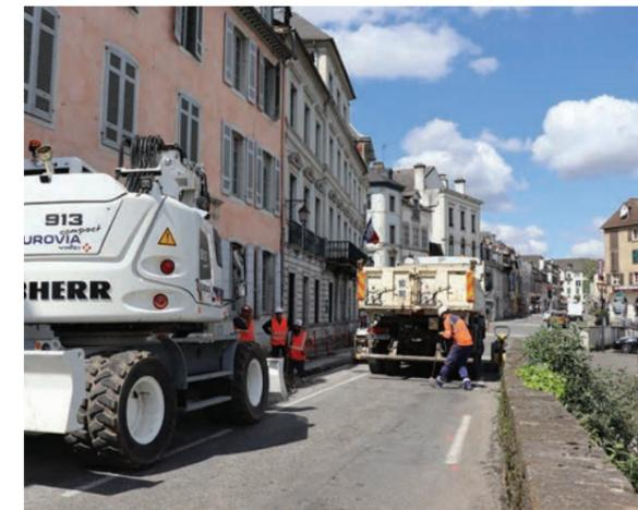
Les canalisations dataient de plus de 70 ans et souffraient de ruptures fréquentes. Les branchements étaient en plomb. Il fallait rénover le réseau de la rue Adoue. Ce chantier a été inscrit au plan pluriannuel de la régie d'eau potable.
