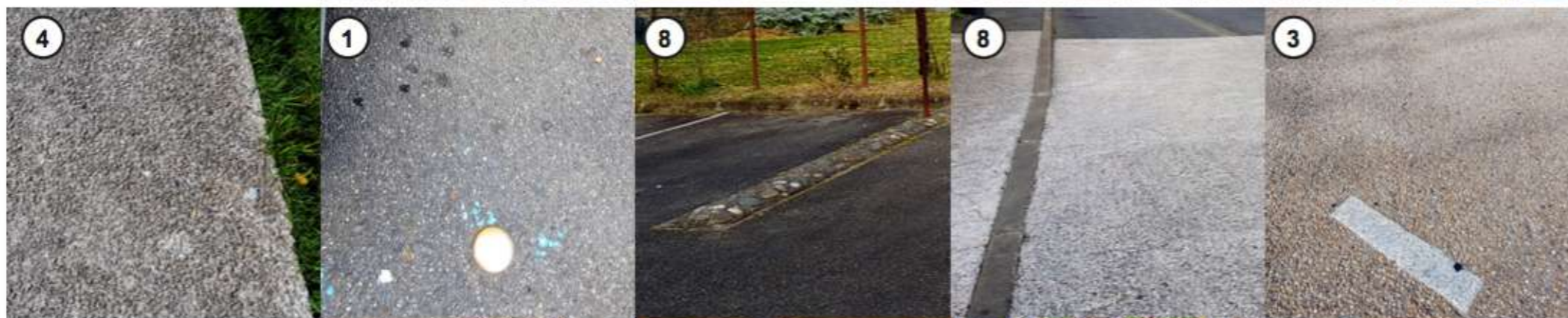
sol minéral compact bétons (désactivés, balayés, lissés...), enrobés (colorés, grenailés)...
