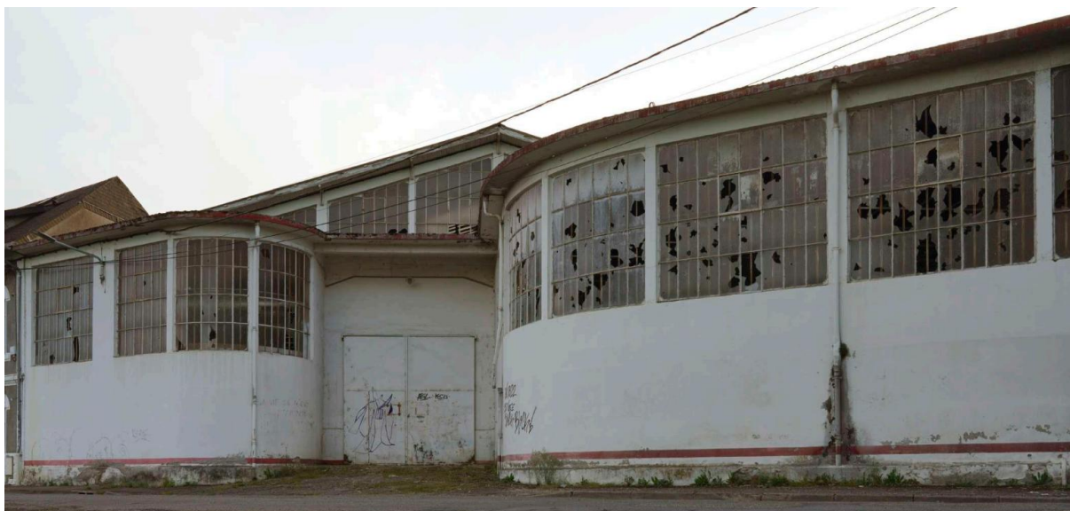
Entrée rue Rocgrand
