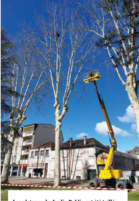
Les platanes du Jardin Public ont été taillés. Les ouvriers travaillaient à environ 25 m de hauteur : pas question de souffrir du vertige !
